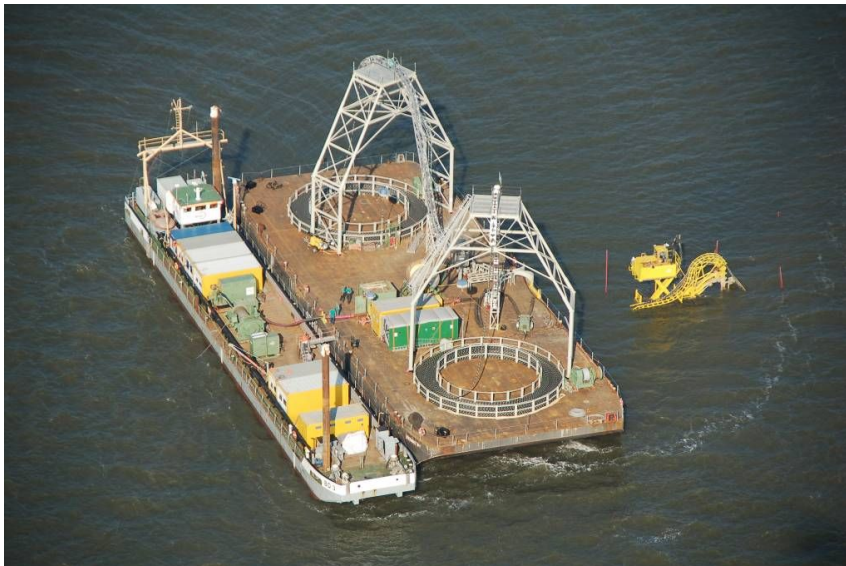
Abbildung 24: Barge/Arbeitsponton mit Versorgungsboot
