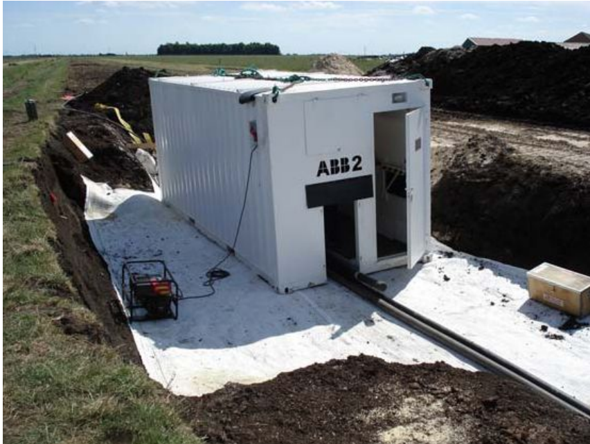
Abbildung 27: Muffengrube mit Arbeitscontainer (Quelle: ABB)
