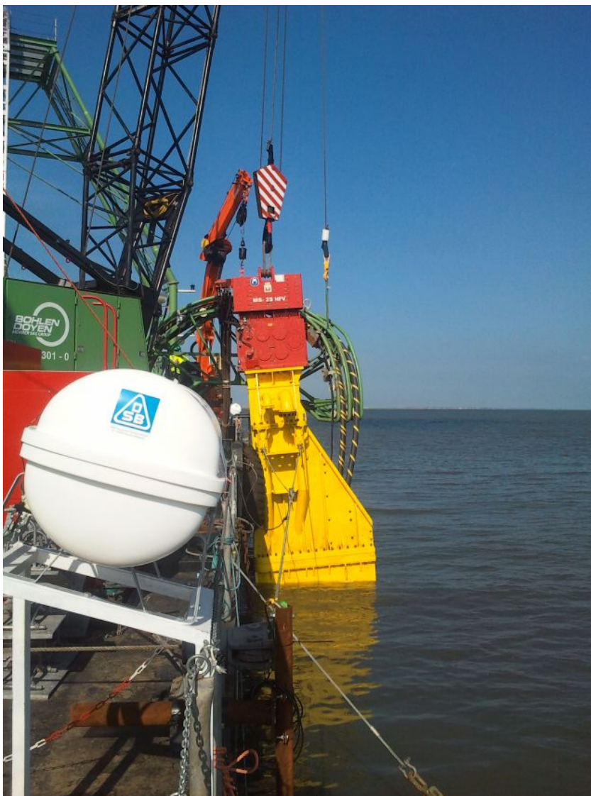
Abbildung 25: Vibroschwert bei der Wattkabelverlegung für BorWin2 (Quelle: TenneT)
