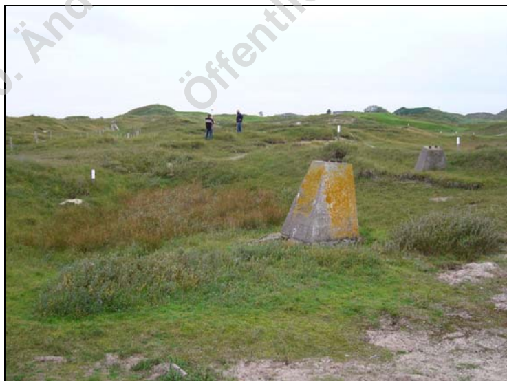
Abb. 8: Zu entfernende Betonfundamente im Süden des bestehenden Golfplatzes
