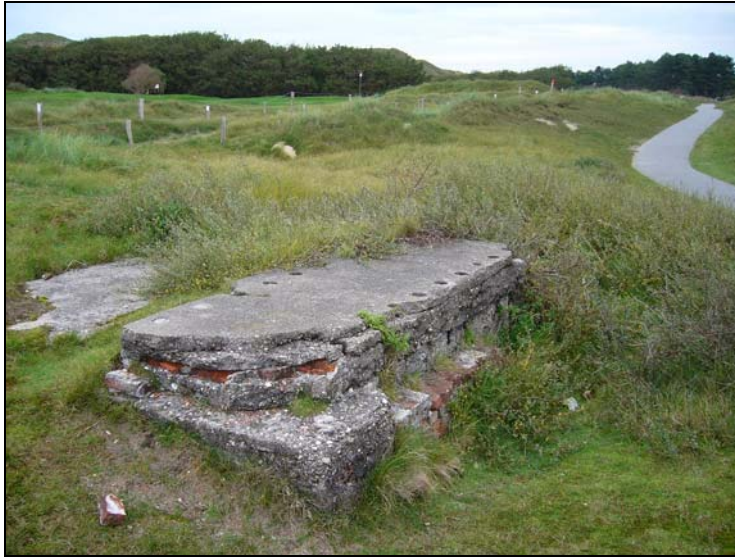
Abb. 9: Zu entfernendes Betonfundament neben dem Fahrrad- und Fußweg
